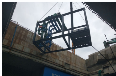
整体吊装至目标机房
