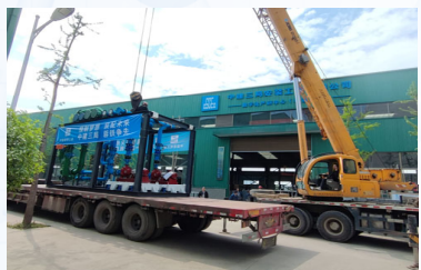
成品模块吊装出厂
