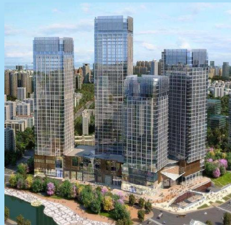
深圳华侨城大厦项目
