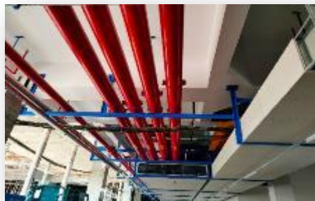
8、现场照图施工
