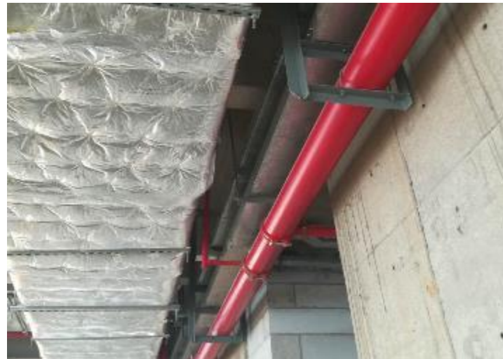
支吊架现场安装图片
