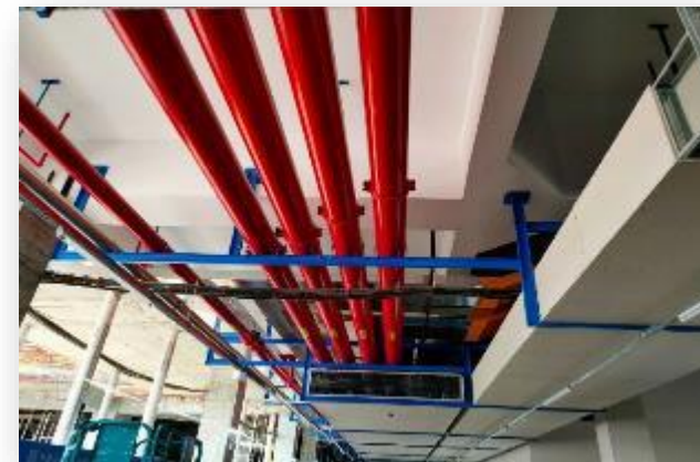
现场安装图片 28
