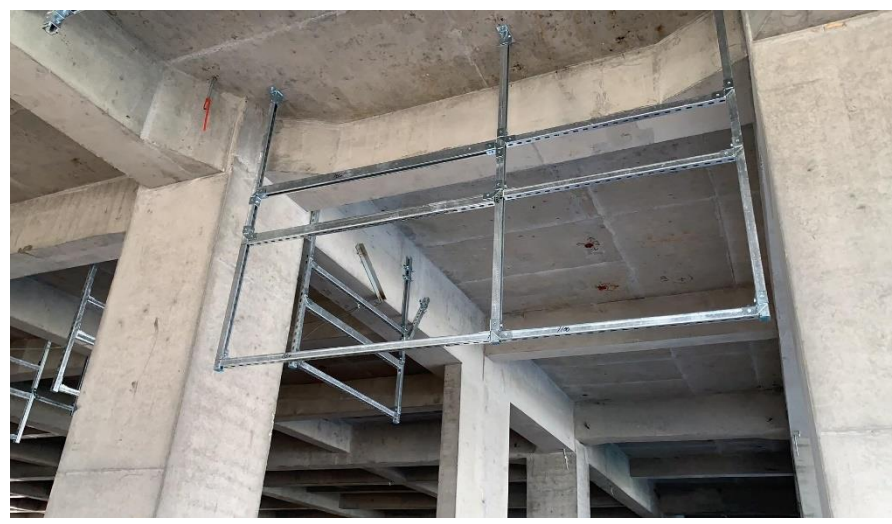
BIM辅助设计- 管线整体预制优化分段+批量化加工+快速安装
