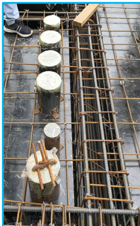
管道井内套管精准定位一次性预埋到位
