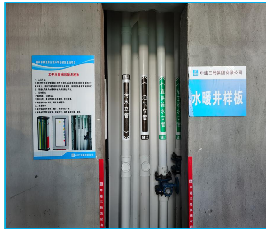
管道井安装样板
