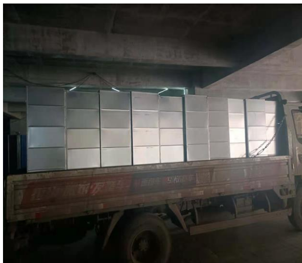
BIM辅助设计- 管线整体预制优化分段+批量化加工+快速安装
