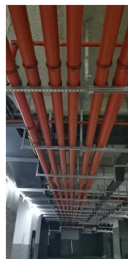
BIM辅助设计- 管线整体预制优化分段+批量化加工+快速安装
